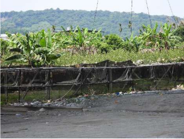
部分阻隔措施缺漏區域已修補完善
