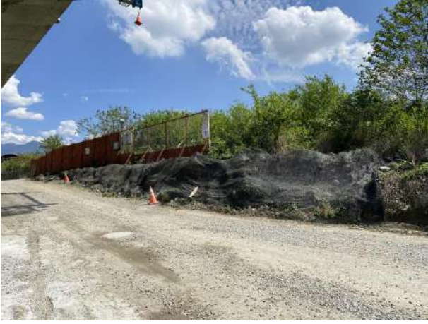
防塵網覆蓋裸露邊坡
