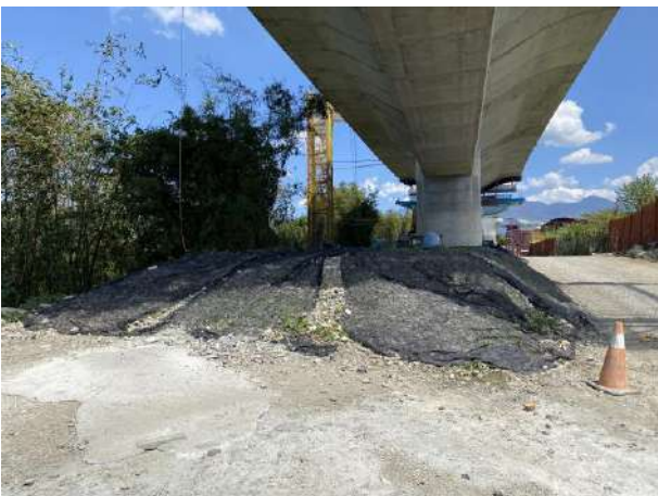
防塵網覆蓋暫置土方
