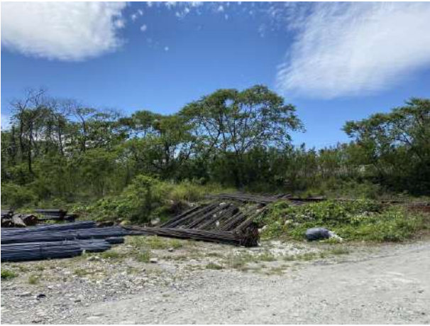
保全樹林未圍設警示帶及物料堆置情形
