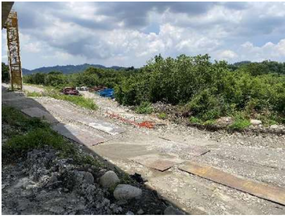
鄰近工區起點處現況
