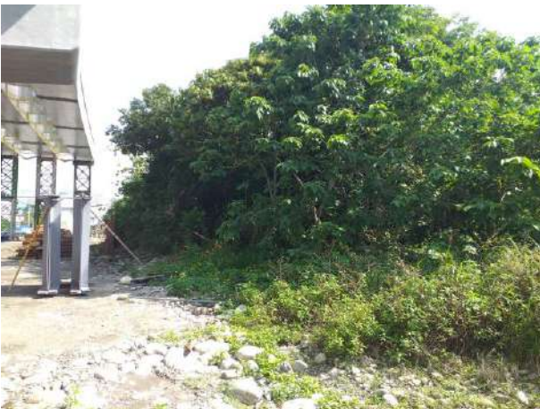
部分無法架設圍籬之區域可設置警示帶
