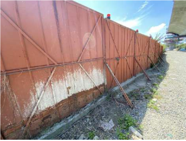
全阻隔式圍籬設置情形
