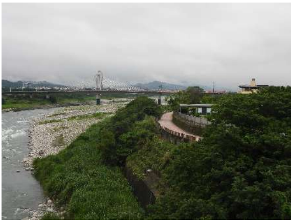
工區現況(東豐鐵橋向上游拍攝)
