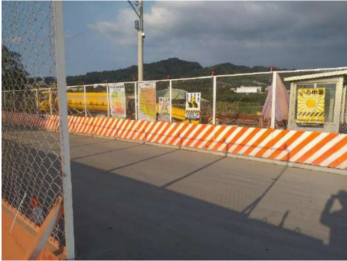
3. 相關施工機具皆放置於既有空地。
