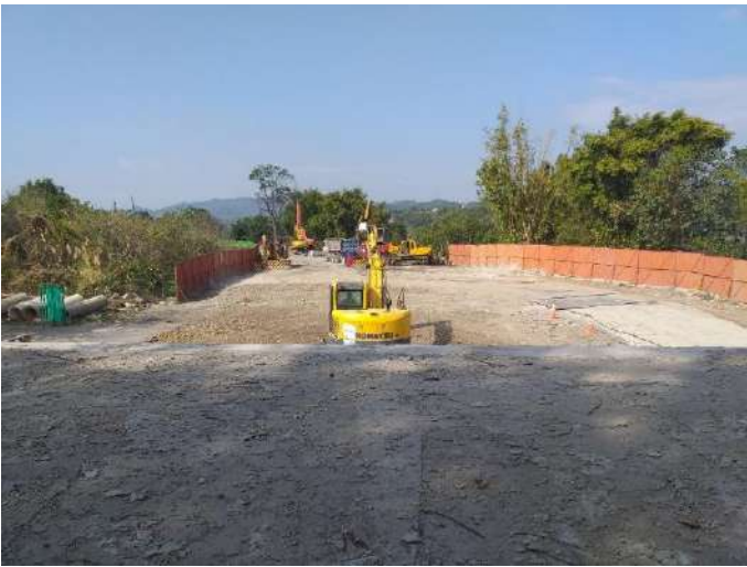
4. 現勘時無發現揚塵，皆有定時灑水於工程機具與大車行駛的道路上。
