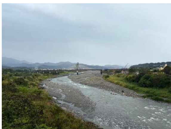
工區現況(東豐鐵橋向上游拍攝)
