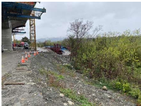
鄰近工區起點處現況
