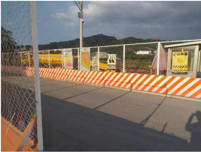
3. 相關施工機具皆放置於既有空地。
