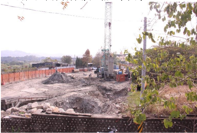
4. 現勘時無發現揚塵，皆有架設鋼板與定時灑水於工程機具與大車行駛的道路上。
