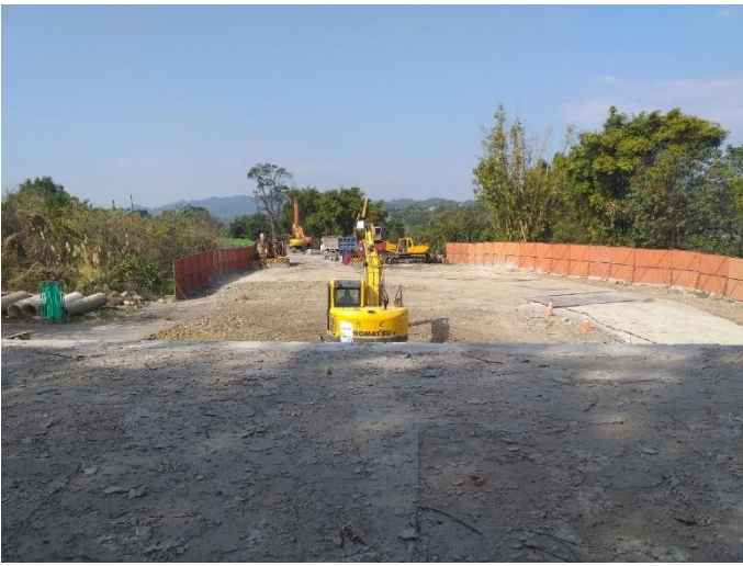
4. 現勘時無發現揚塵，皆有定時灑水於工程機具與大車行駛的道路上。
