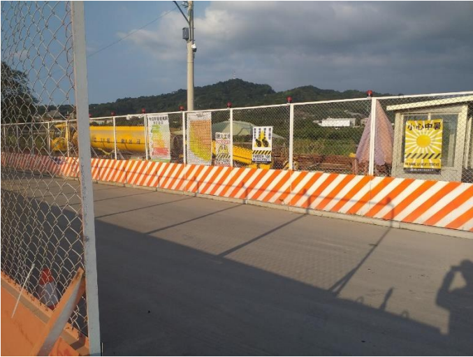
3. 相關施工機具皆放置於既有空地。
