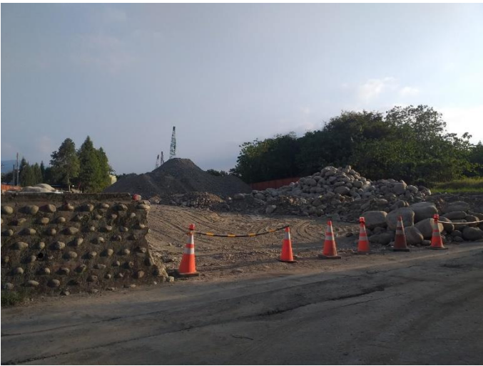
4. 現勘時無發現揚塵，但仍建議設置防塵網於裸露土上方，或定時灑水於工程機具與大車行駛的道路上。
